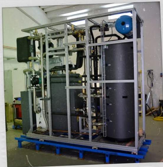
I Plug-in-Modulens rack finns inredelar, styrning, tank, cirkulationspumpar och tillskottsvärmekälla. Tack vare att allt placeras tillsammans i ett rack så kan Energy Saves personal konstruera racket i sin helhet innan det placeras i container-modulen och ansluts till luft/vatten-värmepumpens utdelar.
